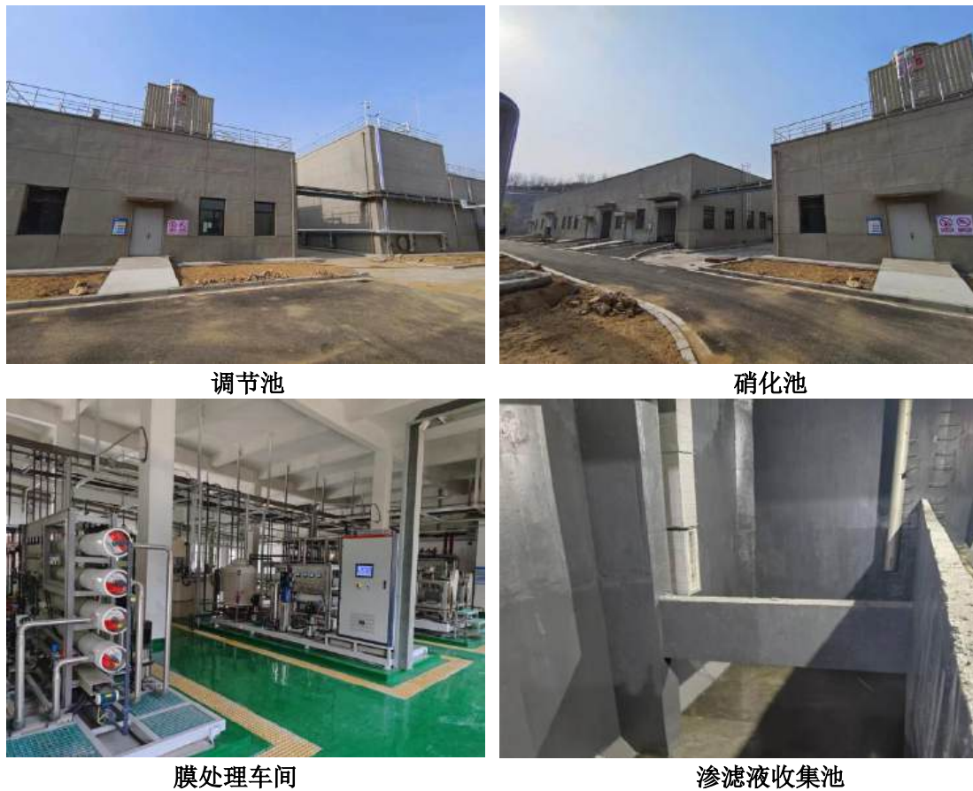
图 2.3-5 渗滤液处理站建设情况图
