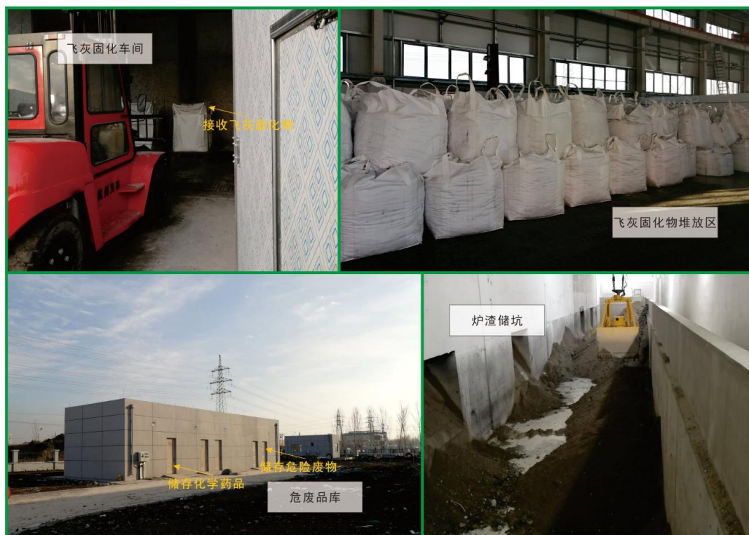
图 2.4-7 现有项目固体废物处置措施实际建设情况图
