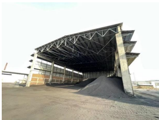
现状主厂区煤仓
