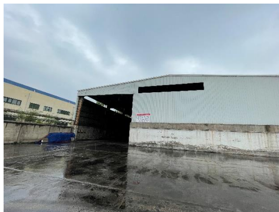
现状赛轮厂区煤仓
