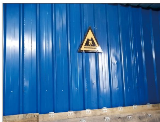
危废暂存间改为仓库
