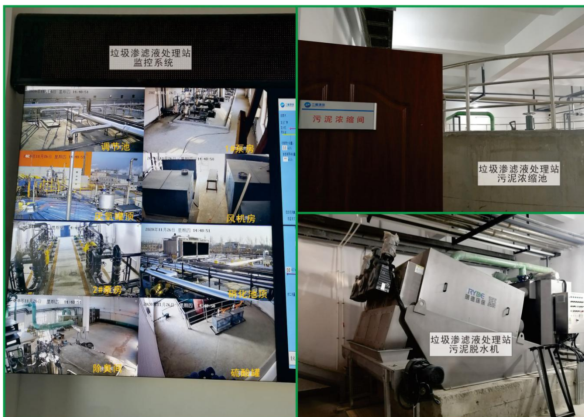
图 4.2 项目废水处理设施实际建设情况图
