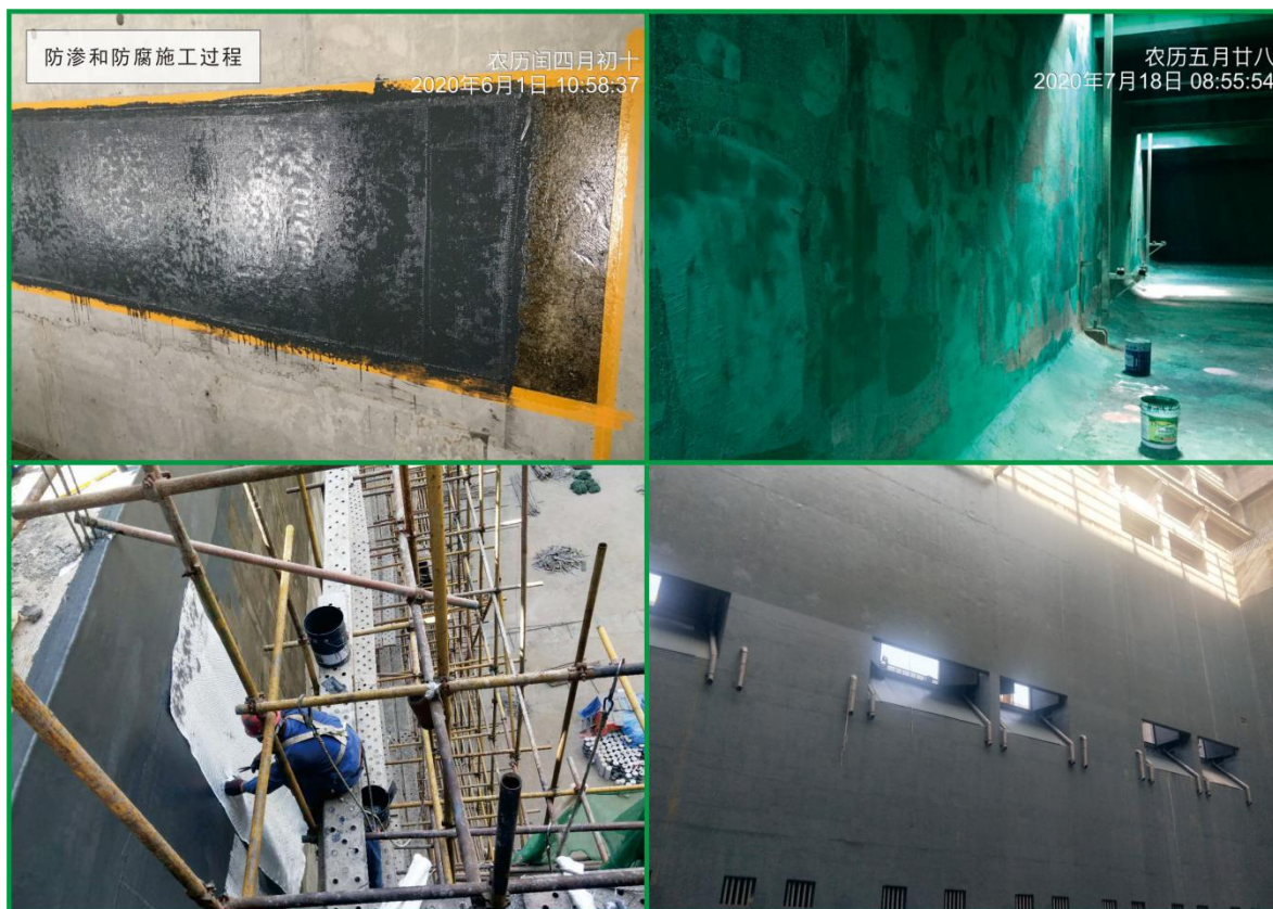
图 4.8 项目防渗和防腐施工过程图
