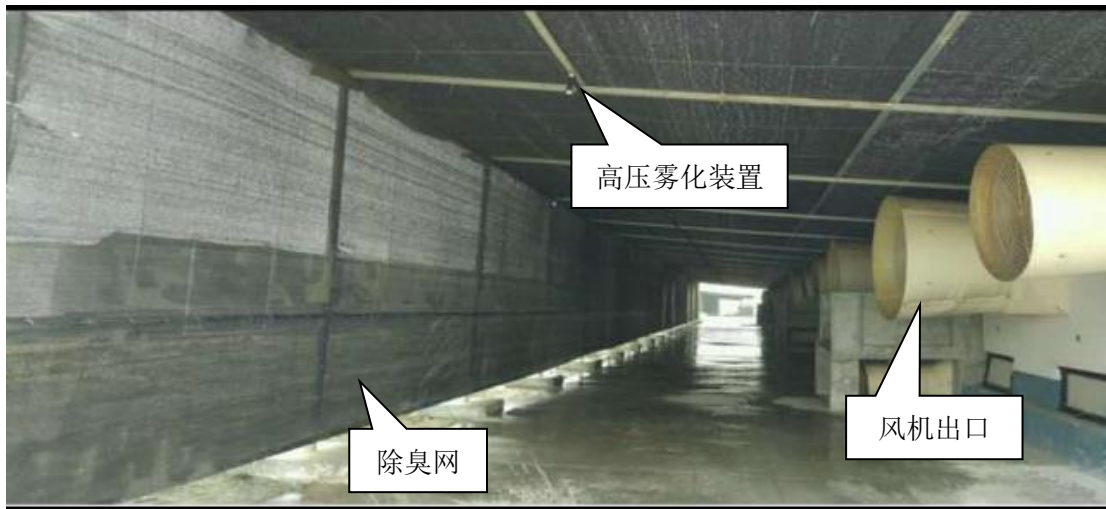
图 3.12-6 除臭网及高压雾化装置安装示意图
