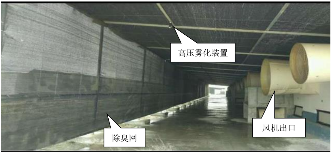
图 3.12-6 除臭网及高压雾化装置安装示意图
