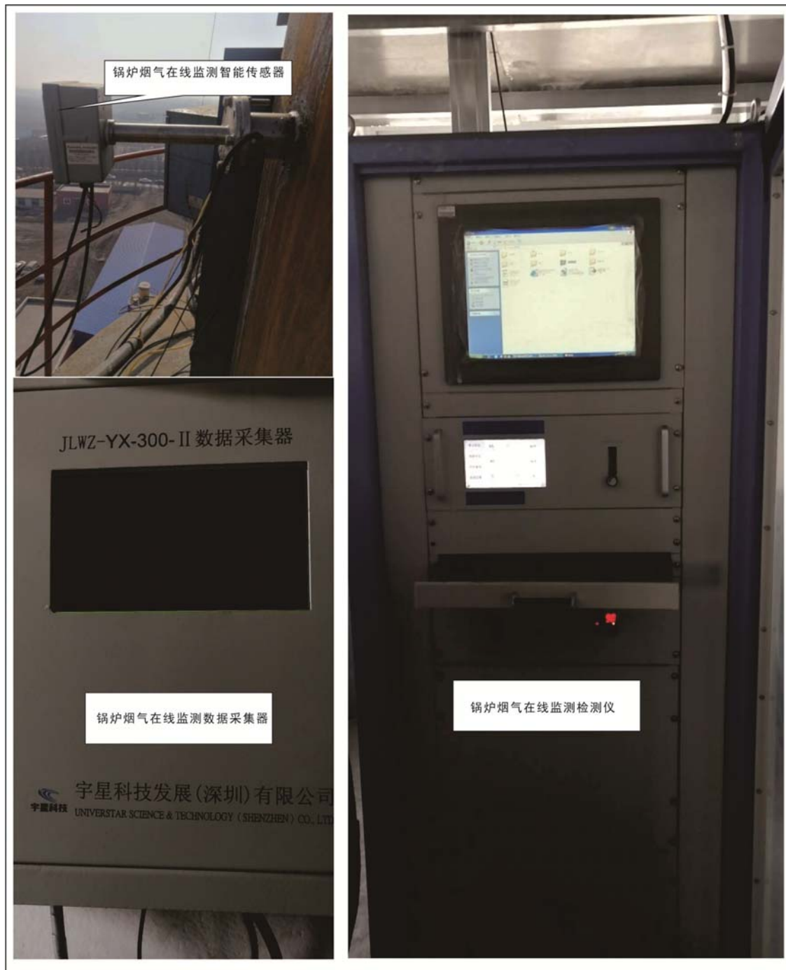
图 3.2-3 (3) 项目现场照片
