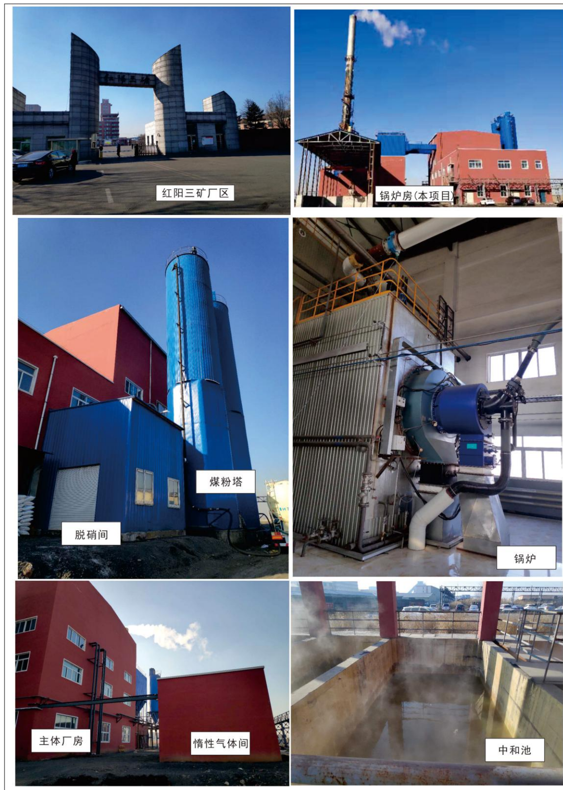
图 3.2-3 (1) 项目现场照片
