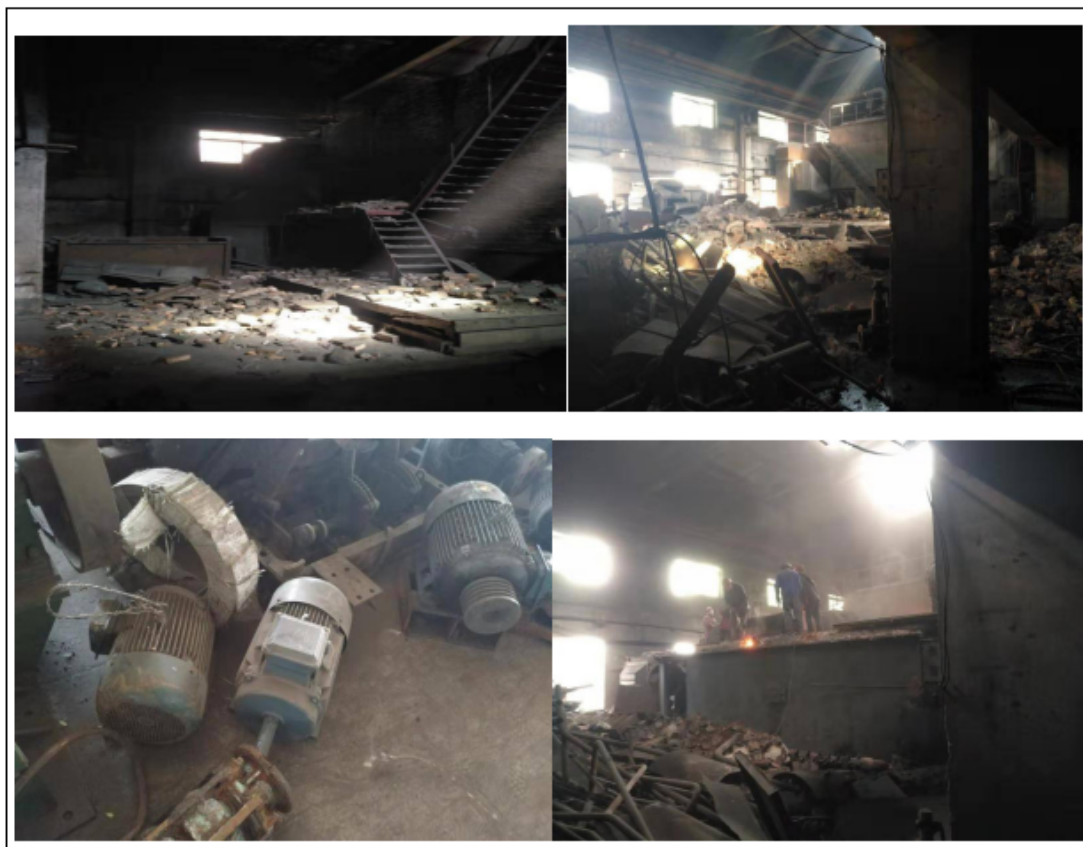
图 4.2-7 原锅炉房拆除照片
