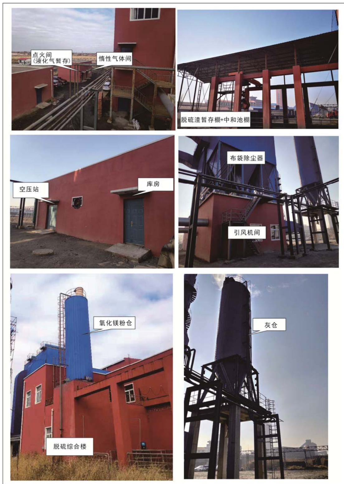
图 3.2-3 (2) 项目现场照片
