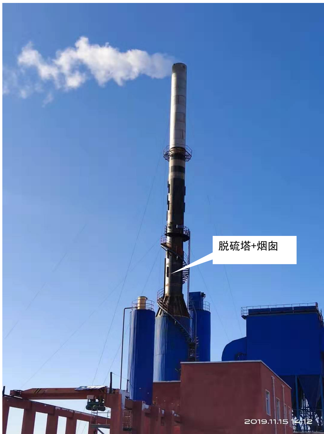
图 4.1-3 脱硫塔和锅炉烟囱
